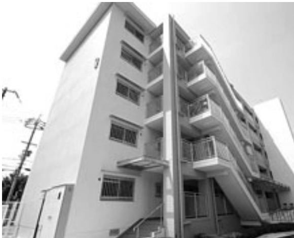
住戸改善された9号棟（北側）
