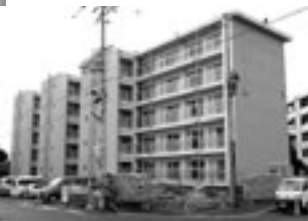
エレベーターを設置した9号（南側）
