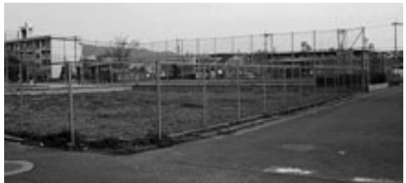
再生前の幸第2公園（北西側）
