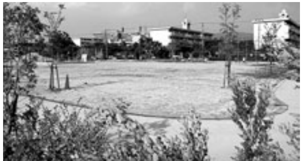
再生後の幸第2公園（南西側）
