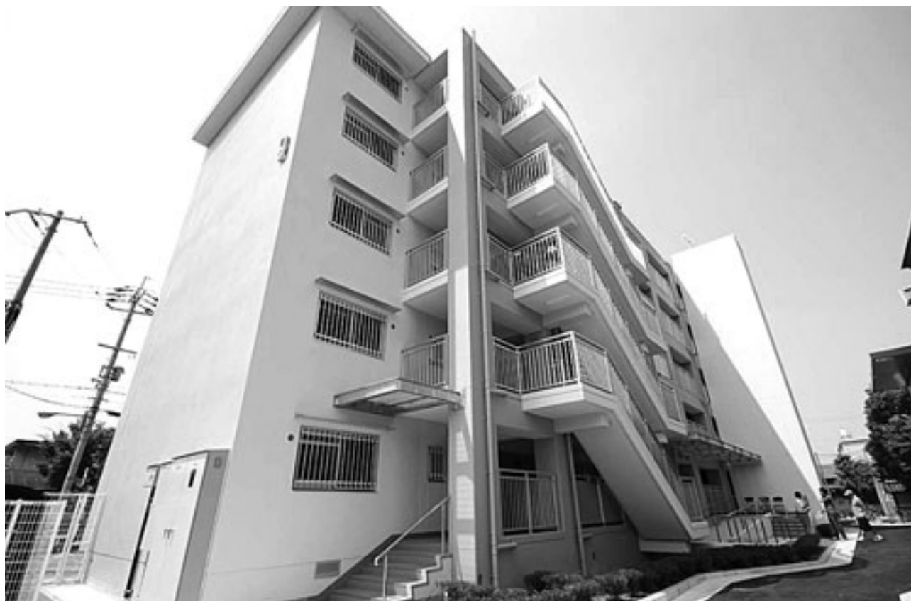
八尾市西郡地域で住戸改善された住宅
