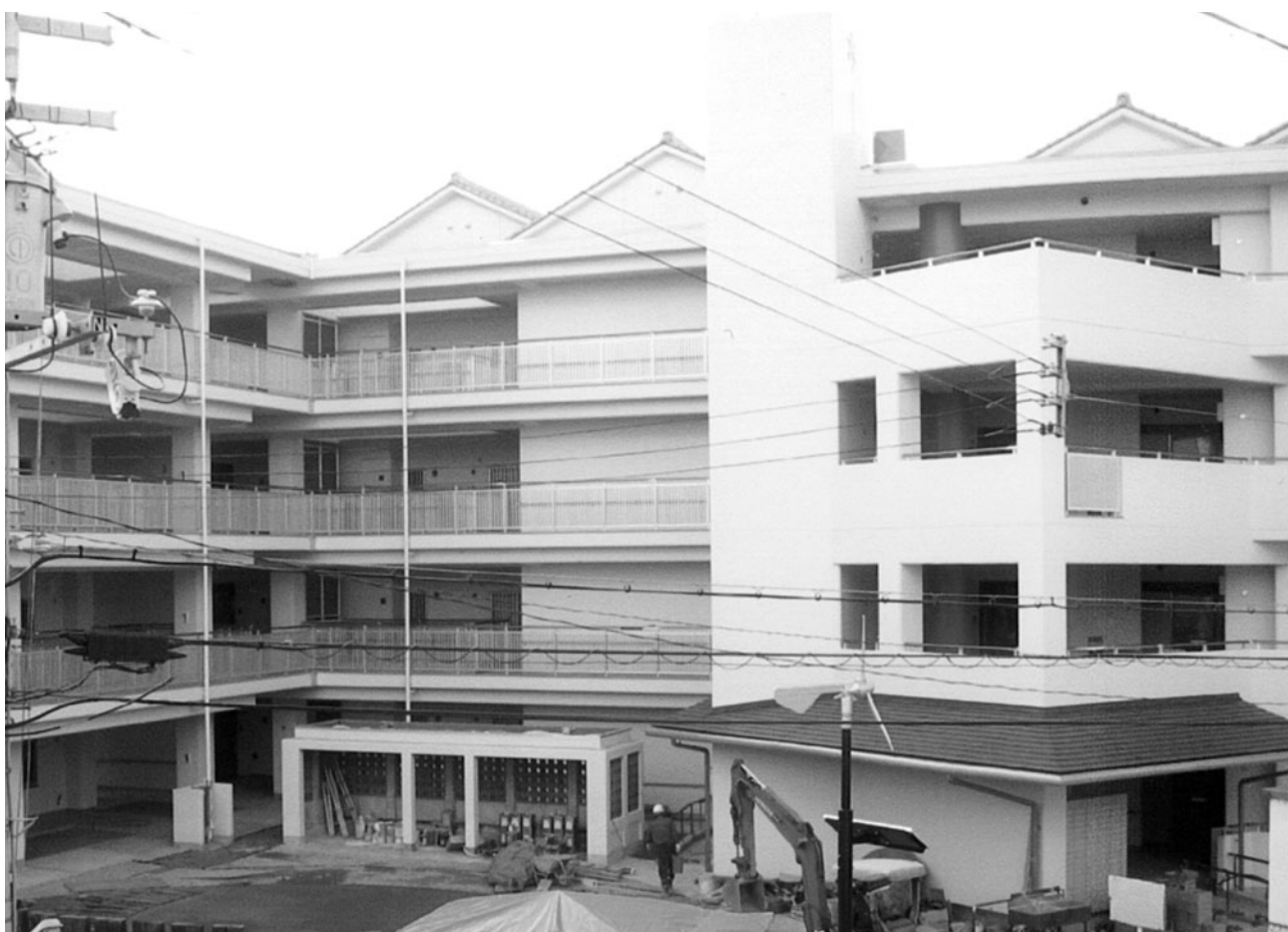
富田林市若松団地で完成間近の建替え住宅
