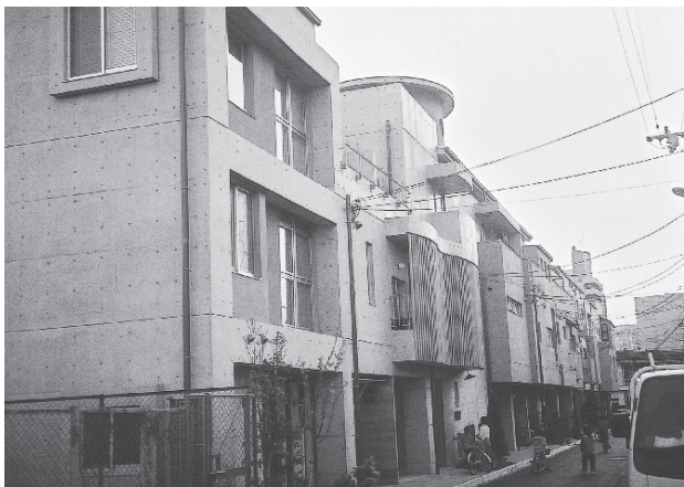
住む人のつながりを大切に設計と一帯ごとの思いが現れている外観
