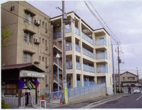
幸第2団地のエレベーター工事
